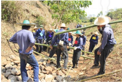
ชาวบ้านช่วยกันสร้างฝายชะลอน้ำ
