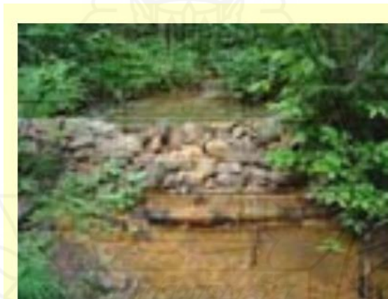
ภาพ ฝายต้นน้ำลำธารแบบเรียงด้วยหินก้อนข้างถาวร (ที่มา: http://scratchpad.wikia.com )
