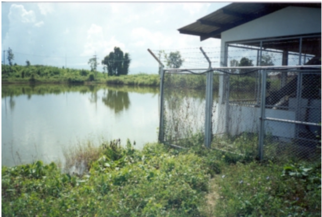
ภาพที่ 2.3 บ่อพักน้ำทิ้งที่เกิดขึ้นจากกระบวนการทำเหมืองถ่านหินลิกไนต์แม่เมาะ (Sump D)
