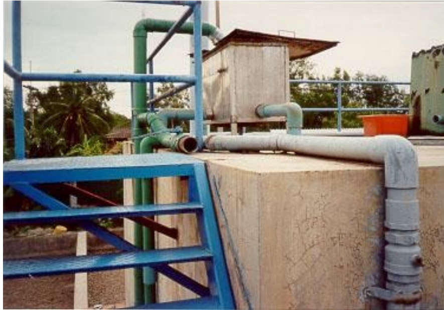
ภาพที่ 3.1 การสูบน้ำจากบ่อผสมรวมเข้าสู่บ่อปฏิกิริยาไร้อากาศที่ต้องกรองผ่านแผ่นกรอง 2 ชั้น เป็นจุดเก็บตัวอย่างน้ำเสียก่อนการบำบัด
