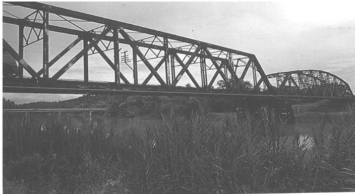
สะพานรถไฟข้ามแม่น้ำหลังสวน
