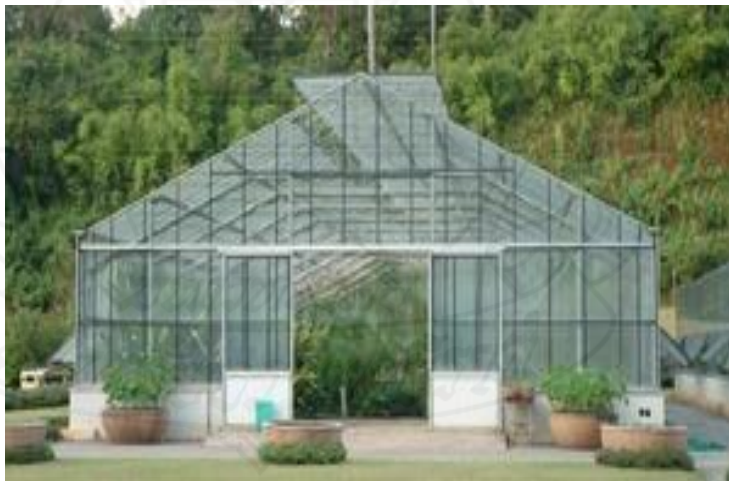
ภาพที่ 2.7 โรงเรือนหลังคาหน้าจั่วแบบสมมาตร
