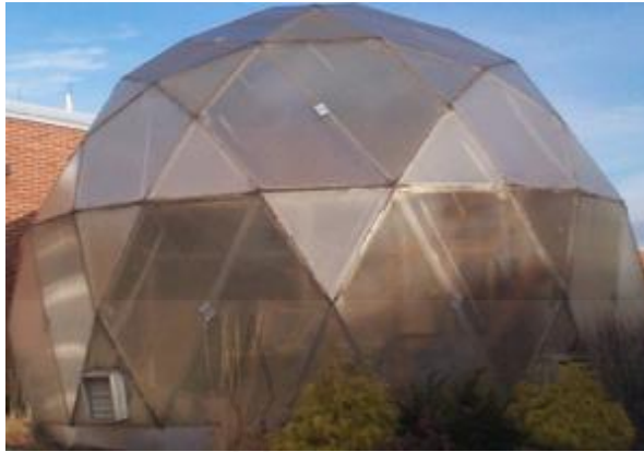
ภาพที่ 2.12 โรงเรือนหลังคาครึ่งวงกลม
