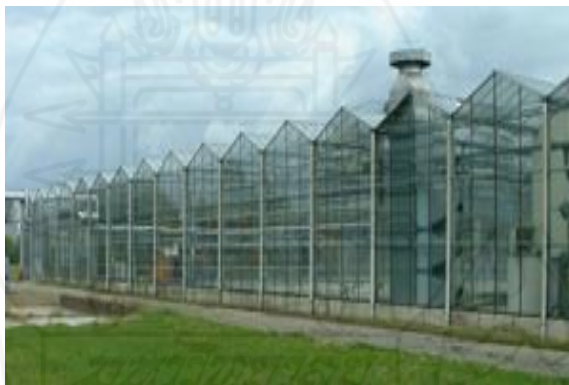
ภาพที่ 2.13 โรงเรือนหลังคาต่อเนื่อง
