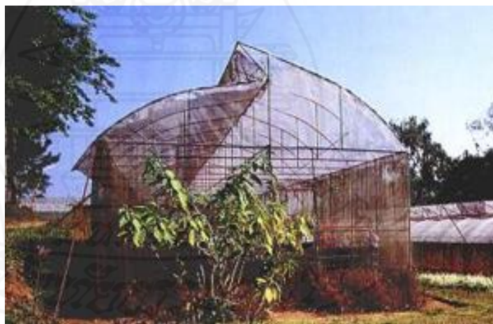
ภาพที่ 2.11 โรงเรือนหลังคาครึ่งวงกลมเหลื่อม (โรงเรือน ก.ไก่)
