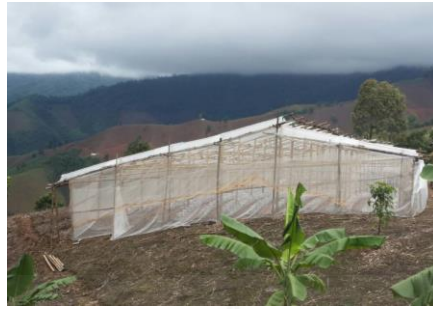
ภาพที่ 2.16 โรงเรือนหลังคาหน้าจั่วแบบไม่สมมาตร ที่มา: โรงเรือนปลูกพริกหวาน โครงการขยายผลโครงการหลวง จังหวัดน่าน
