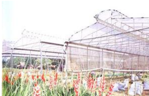
ภาพที่ 2.8 โรงเรือนหลังคาหน้าจั่วสองชั้น
