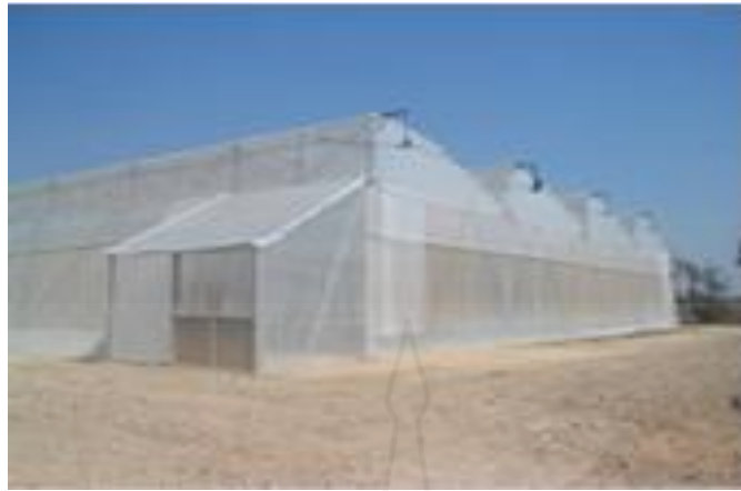
ภาพที่ 2.2 โรงเรือนแบบพินเลื่อย
