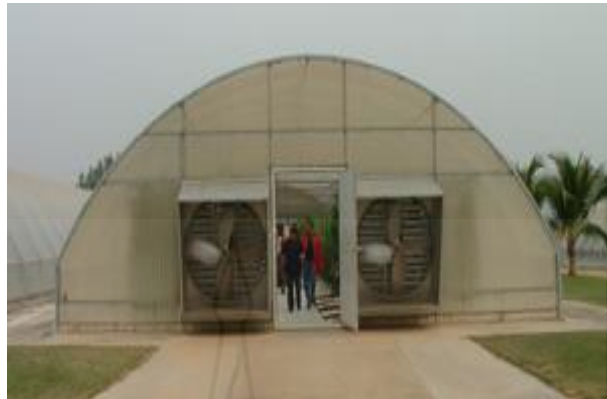
ภาพที่ 2.10 โรงเรือนหลังคาครึ่งวงกลม
