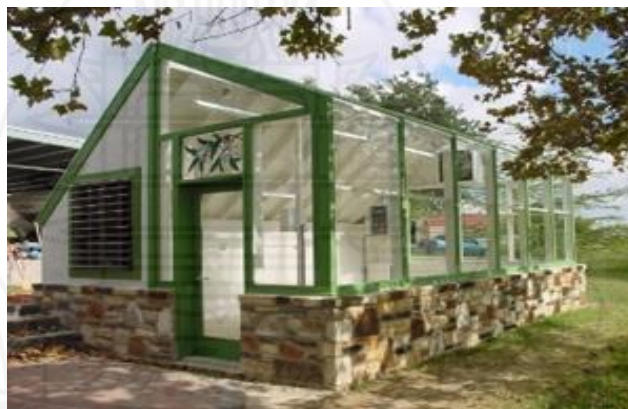
ภาพที่ 2.9 โรงเรือนหลังคาหน้าจั่วแบบไม่สมมาตร
