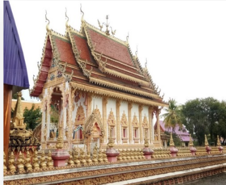
ภาพที่ 40 บริเวณวัดสำโรงเกียรติ
