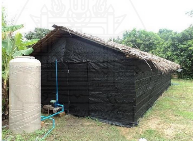
ภาพที่ 2 โรงเรือนเห็ดมุงหลังคาด้วยใบจาก ด้านข้างและหน้าจั่วใช้ผ้าแสลดำแบบหนา
