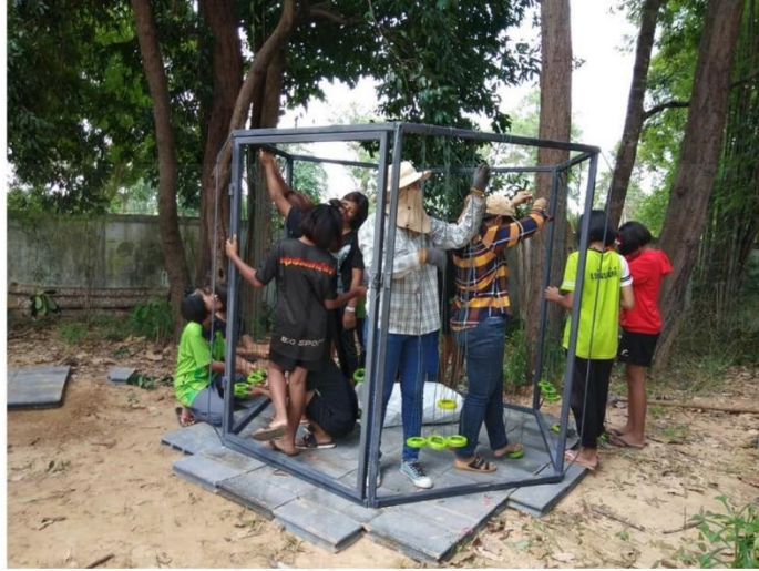
ภาพที่ 10 ปูพื้นด้วยอิฐบล็อกเพื่อโครงเหล็กให้โรงเรียนสม้าเสมอและแขวนเชือกเพื่อวางก้อนเห็ด
