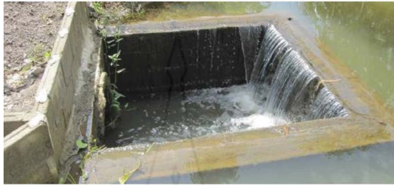
ภาพที่ 2.7 แสดงอาคารน้ำล้น
