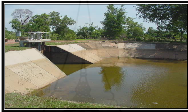
ภาพที่ 2.3 ประตูระบายของท่อส่งน้ำปากคลองส่งน้ำสายใหญ่ขวา
