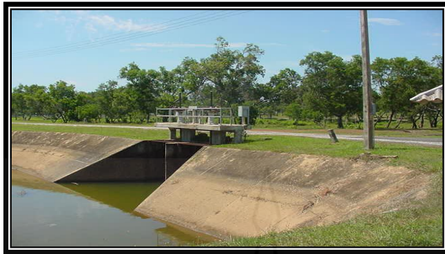
ภาพที่ 2.5 ประตูระบายของท่อส่งน้ำปากคลองส่งน้ำสายใหญ่ฝั่งซ้าย
