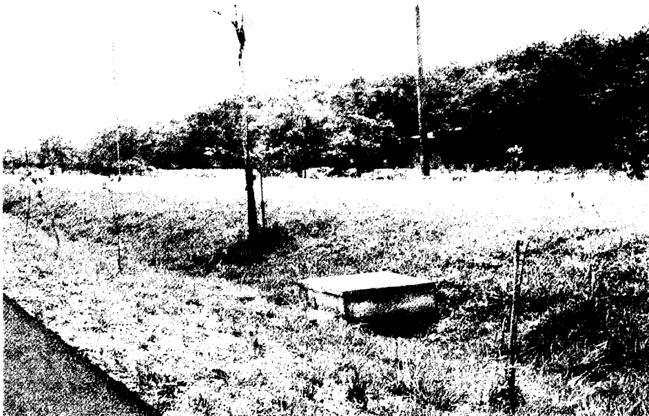
ภาพที่ 2.2 ต้นไม้และวัตถุแข็งในเขตปลอดภัยเป็นสิ่งอันตรายต่อผู้ขับขี่ ซึ่งสามารถป้องกันได้
