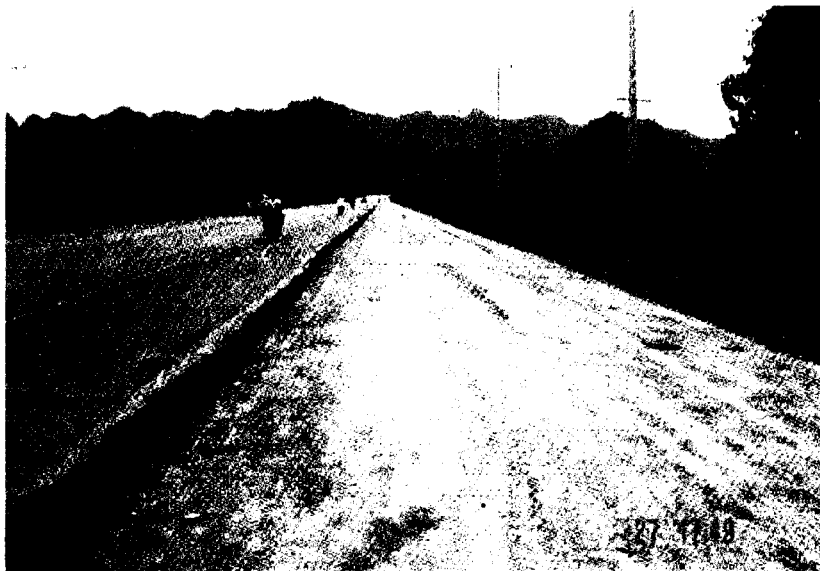
ภาพที่ 2.9 ความแตกต่างของระดับถนนเดิมกับถนนที่กำลังก่อสร้าง เป็นอันตรายต่อผู้ใช้ทางโดยเฉพาะเวลากลางคืน เนื่องจากขาดอุปกรณ์บอกแนวขอบถนน
