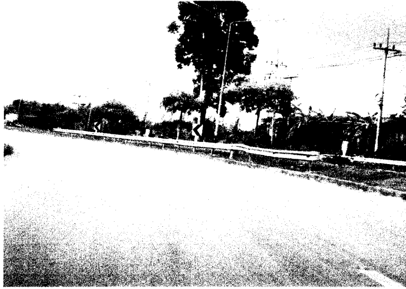
ภาพที่ 4.12 แสดงการติดตั้งราวกันอันตราย .
