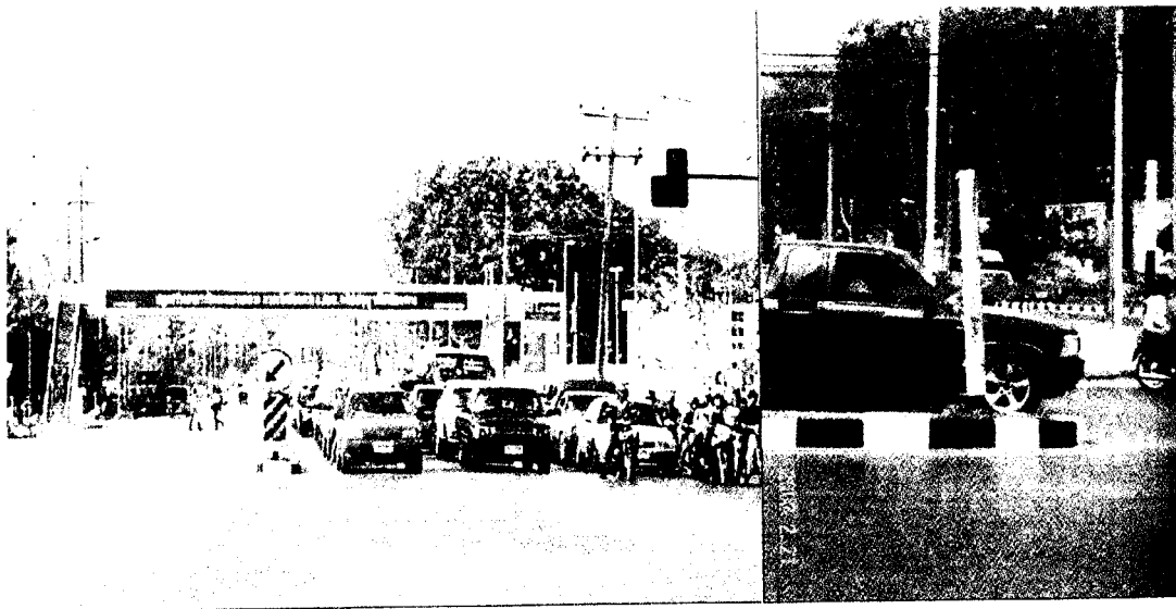
ภาพที่ 2.13 ขนาดของเสาที่ใช้ติดตั้งป้ายบอกสิ่งกีดขวางซึ่งใหญ่เกินความจำเป็น และเป็นอันตรายต่อผู้ขับขี่ที่พลาดพลั้ง
