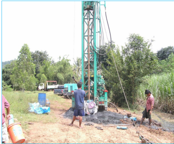
ภาพที่ 4.30 ชุดเจาะบ่อบาดาล ได้รับงบประมาณจากกรมทรัพยากรน้ำบาดาล
