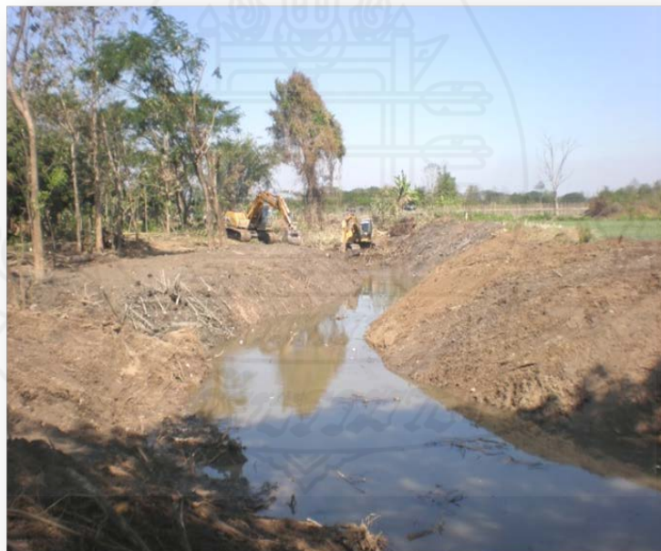
ภาพที่ 4.31 ชุดลอกลำห้วย (โครงการของกระทรวงทรัพยากรธรรมชาติและสิ่งแวดล้อม)
