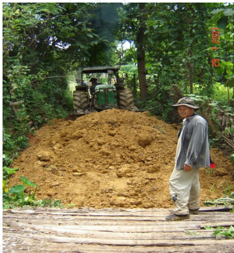
ภาพที่ 4.27 ถนนเข้าพื้นที่การเกษตร ระยะทาง 2,500 เมตร (โดยไม่ใช้งบประมาณของทางราชการ) จากบสมทบภาคประชาชน จำนวน 150,000 บาท
