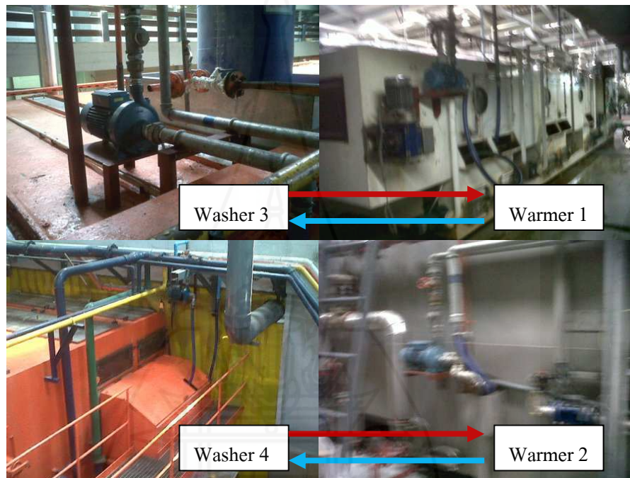
ภาพที่ 4.15 การแลกเปลี่ยนความร้อนระหว่างเครื่องล้างขวดกับเครื่องอุ่นน้ำหวาน
