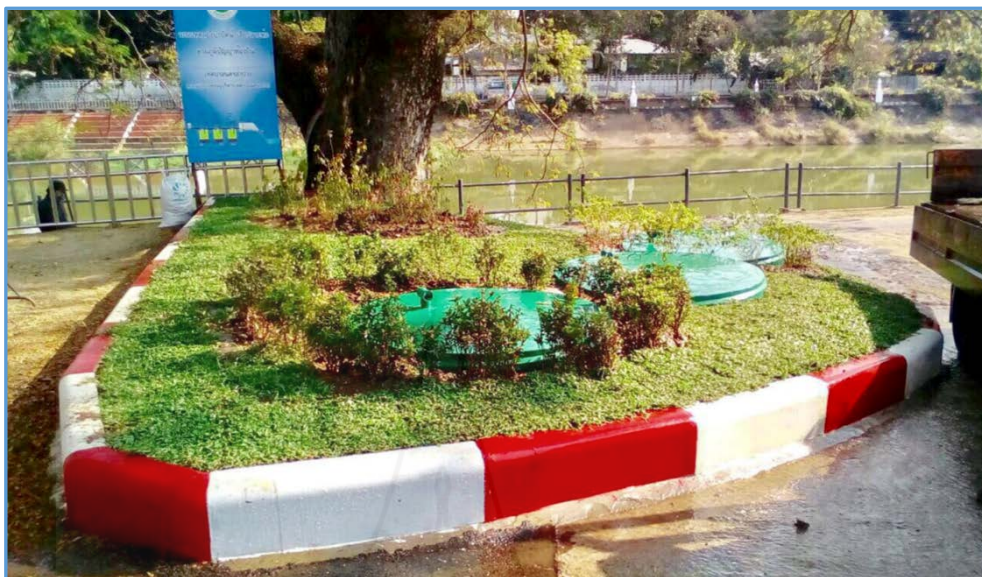
ภาพที่ 4.4 บ่อบำบัดน้ำเสียปลายทางแบบภูมิปัญญาท้องถิ่น แห่งที่ 1 บริเวณถนนป่าไม้ (เชิงสะพานช้างเผือก)
