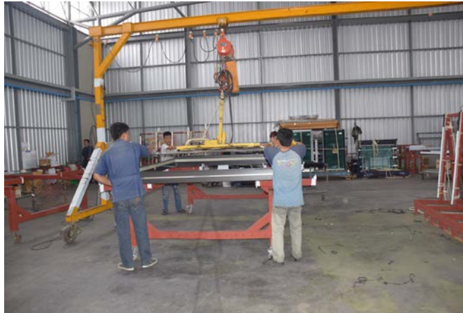
ภาพที่ 4.39 การลำเลียงกรอบอลูมิเนียมเพื่อนำไปติดตั้งกระจก
