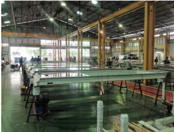
ภาพที่ 2.4 หน่วยงานประกอบและติดตั้งกระจก
