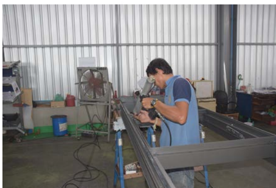
ภาพที่ 4.16 การประกอบกรอบอลูมิเนียมและยาซิติโคนป้องกันการรั่วซึม
