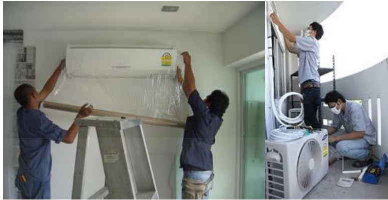
ภาพที่ 2.14 การติดตั้งเครื่องปรับอากาศ
