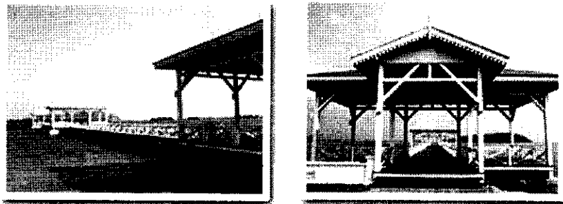
ภาพที่ 2.4 สะพานอัญญางค์
