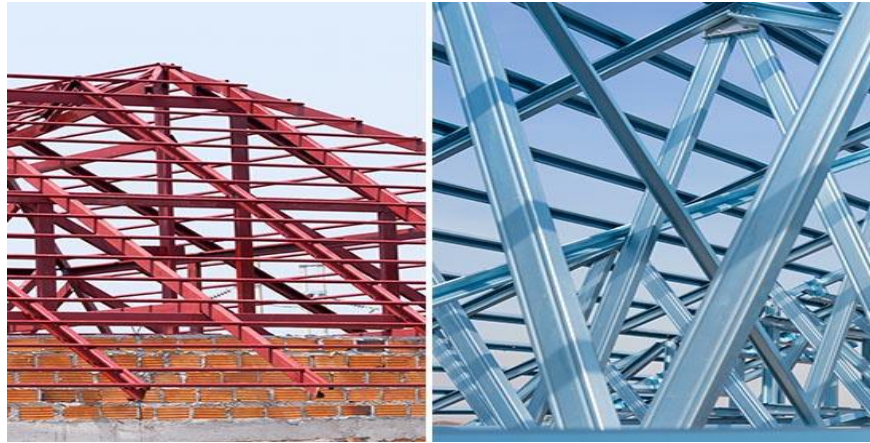
รูปที่ 3 รูปโครงหลังคาเหล็กรูปพรรณ กับ รูปโครงหลังคาสำเร็จรูป ที่ใช้ในการก่อสร้างบ้านพักอาศัย
