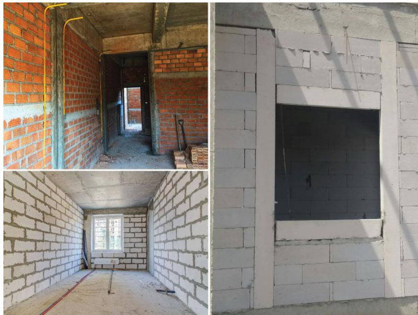
รูปที่ 4 รูปการก่อสร้างผนังโดยใช้อิฐมอญ กับ อิฐมวลเบา และการทำคานทับหลัง
