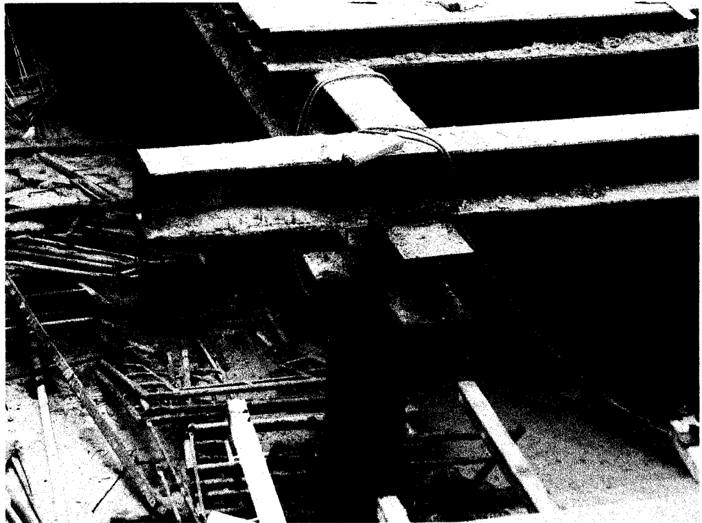
ภาพที่ 4.17 แสดงการติดตั้งเหล็กชั้นใต้ดิน
