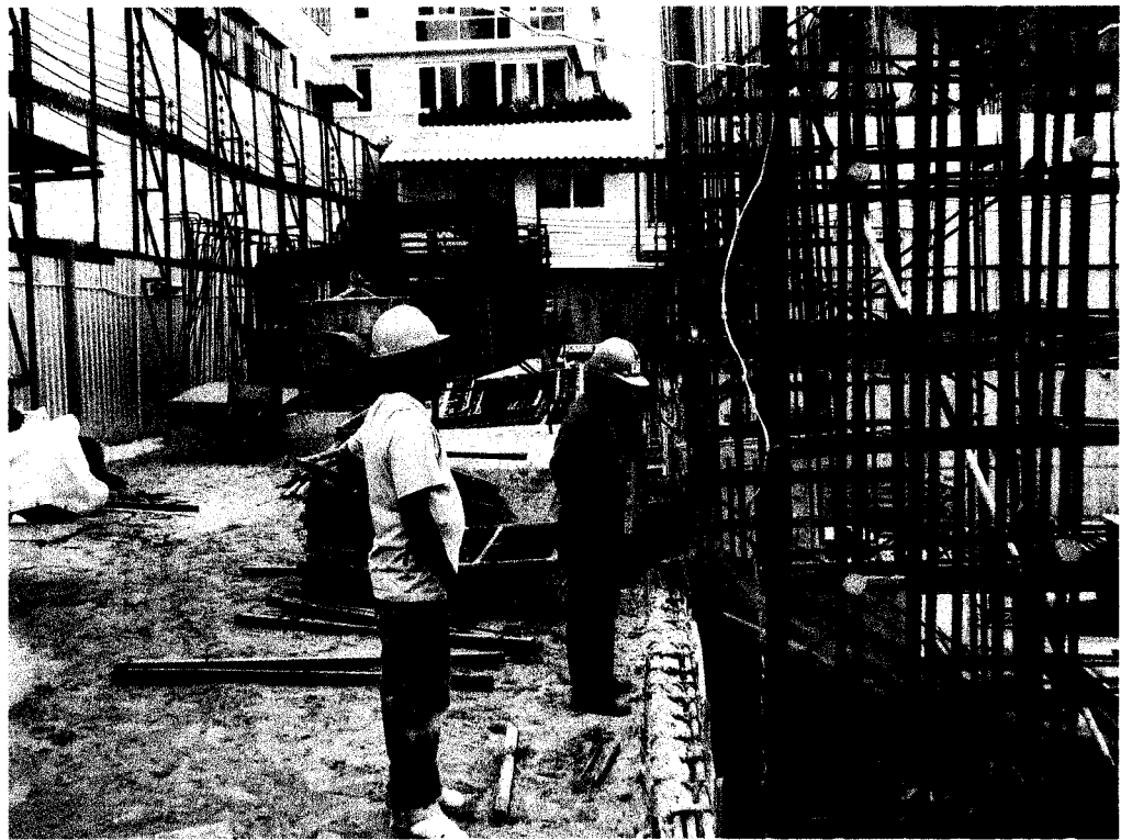
ภาพที่ 4.16 แสดงการติดตั้งเหล็กเสริม
