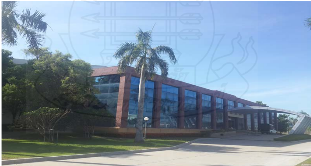
ภาพที่ 2.2 บริษัท นันยางเท็กซ์ไทล์ จำกัด (สาขา นครปฐม พุทธมณฑลสาย 5)
