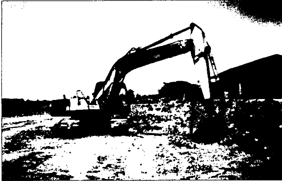
ใช้เครื่องจักรขุดยกทรงเตรียมพื้นที่ปลูก (พฤษภาคม 2545 อำเภอขานนวลลักษบุรี จังหวัดกำแพงเพชร)
