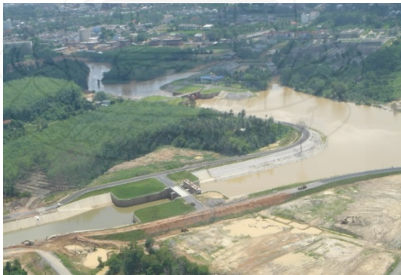
ภาพที่ 1.3 สถานที่ก่อสร้างประตูระบายน้ำหน้าควน แห่งที่ 2
