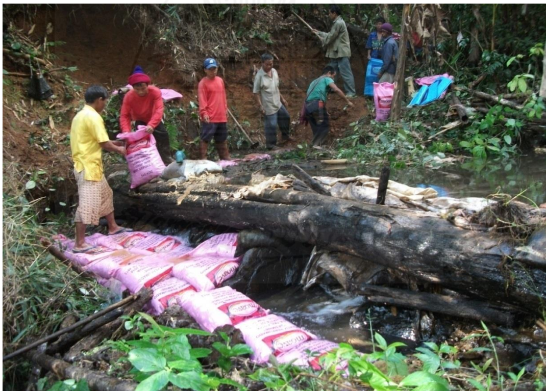
รูปภาพที่ 5.9 กิจกรรมก่อสร้างฝายชะลอความชุ่มชื้นบ้านไม้สะเป่ (ภาพ อบต. ปางหมู)
